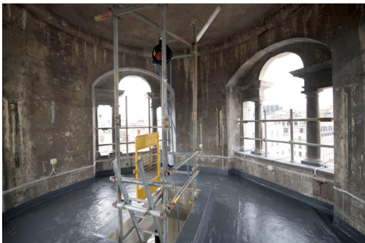
Level 6 Turret fitout
